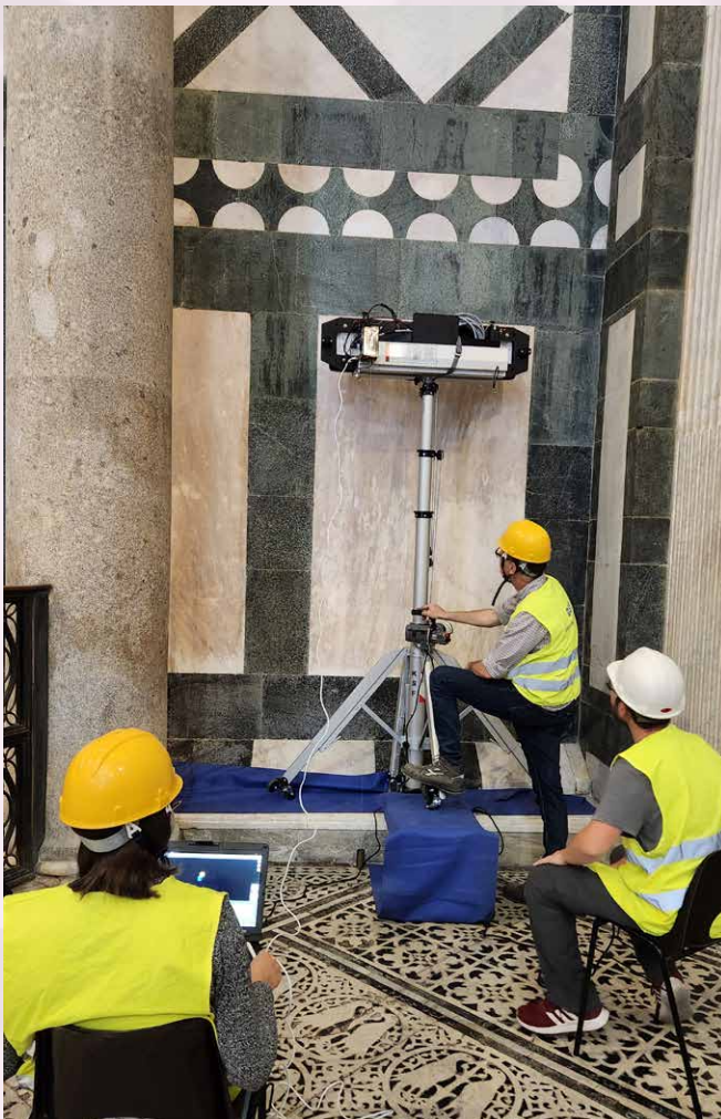
Fig. 2 - Indagine non distruttiva tramite Georadar contactless ( Stream T by IDS Georadar, part of Hexagon ) montato su un elevatore per scansionare in tomografia le pareti del Battistero di San Giovanni a Firenze (fotografia M. Coli).
