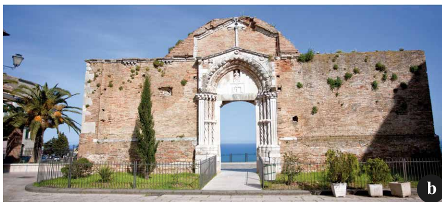
Fig. 7 - La frana di Vasto (Abruzzo, Italia): a) vista del coronamento di frana con la passeggiata panoramica che si affaccia sul versante e sulla adiacente costa; b) portale della chiesa di San Pietro, oggi una "finestra sul mare", gravemente danneggiata durante la riattivazione della frana del 1956 e per questo demolita nel 1959.
